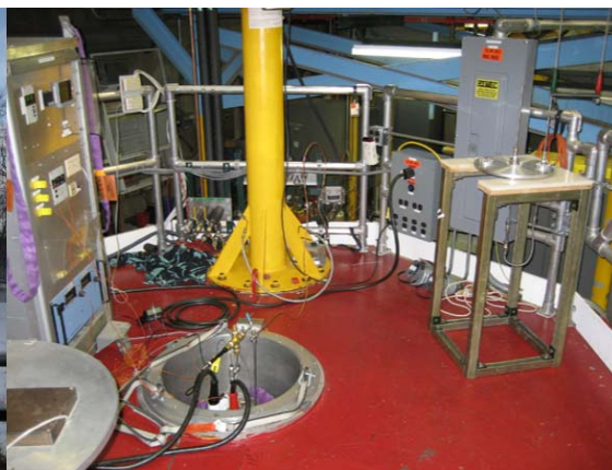
IPNS 実験施設
