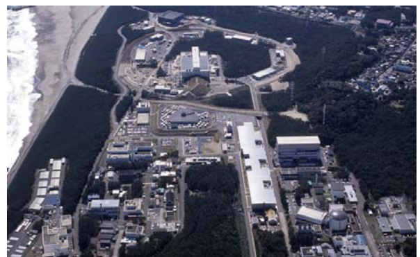
建設中の J-PARC (2006 年 12 月)
